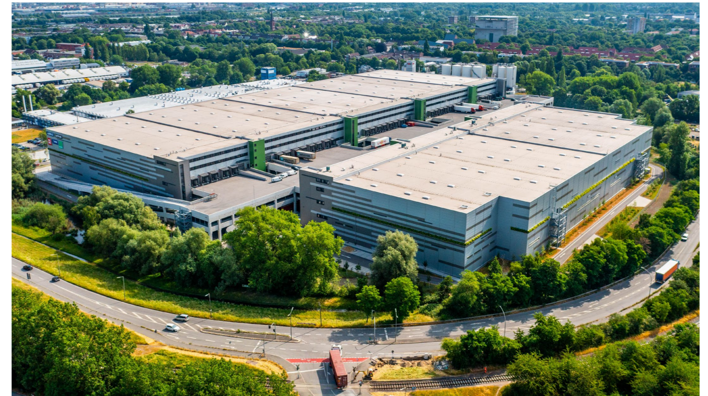
Abb. 9 MACH 2 Logistikzentrum in Hamburg (FOUR PARX GmbH, 2023)
