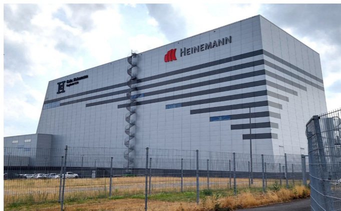
Abb. 8 Hochregallager Heinemann in Erlensee
