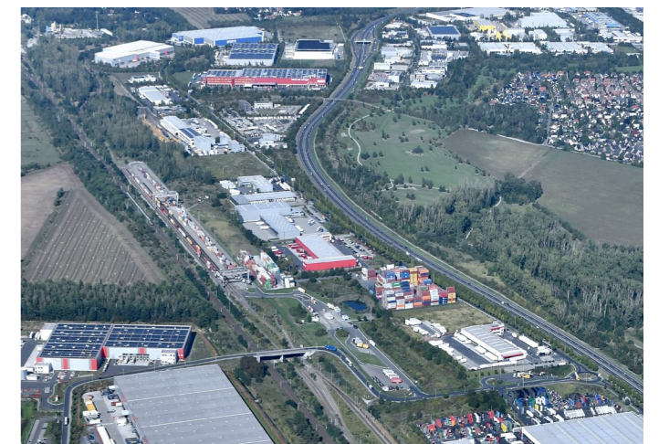
Abb. 34 Containerterminal GVZ Großbeeren bei Berlin (Gemeinde Großbeeren, 2023)
