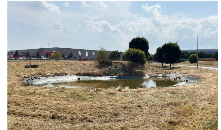
Abb. 21 Versickerungsbecken im Magnapark in Butzbach
