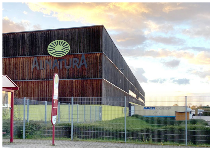
Abb. 73 Holzfassade Alnatura Logistikzentrum in Lorsch
