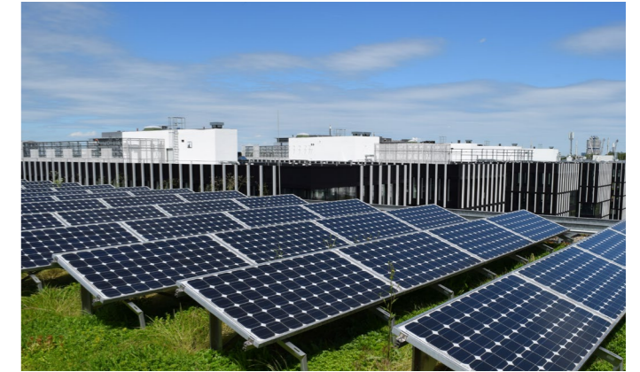
Abb. 14 Kombination Dachbegrünung und Photovoltaik (Bundesvereinigung Gebäudegrün, 2020)
