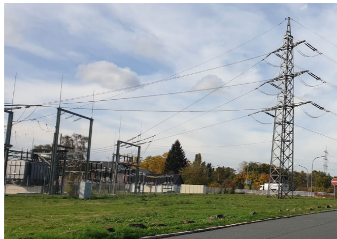
Abb. 28 Umspannwerk in Rüsselsheim
