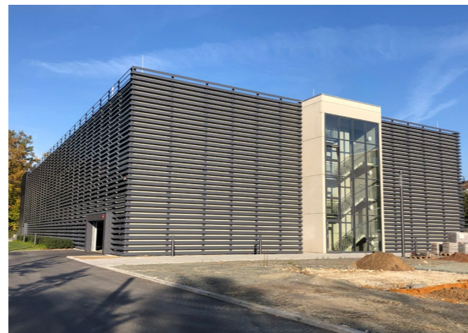
Abb. 39 Parkhaus in Dreieich
