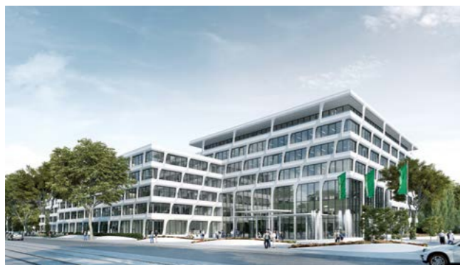
Konzernzentrale HeidelbergCement AG / HeidelbergCement AG Headquarters Heidelberg Generalplanung / general planning 2015-2019
