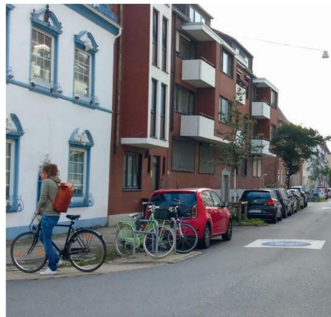
Aufgeplasterte Einengung der Einmündung (Beispiel)
