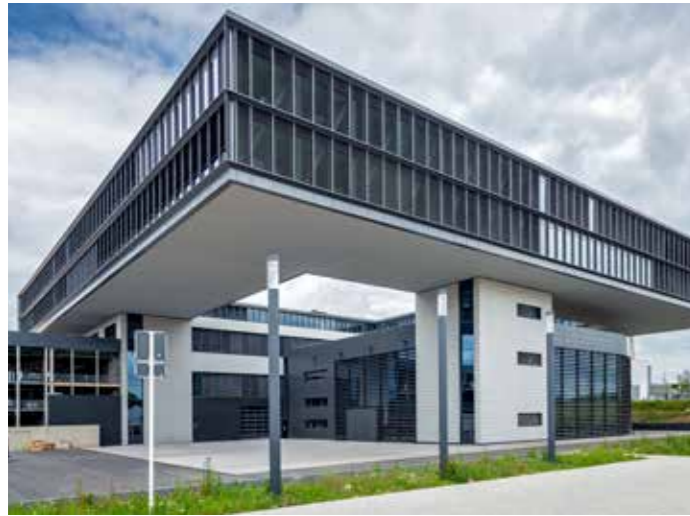
"Schwebende" Büro-Etagen über der Simulatorenhalle
