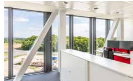
Fassade mit innen liegender Tragstruktur
